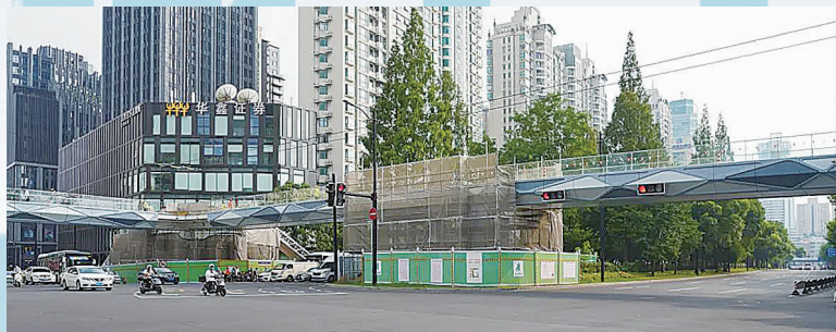
施工中的肇嘉浜路宛平路天桥
