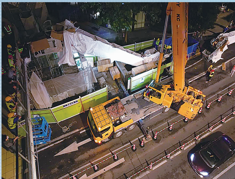
自动扶梯吊装工作正在紧锣密鼓进行中
