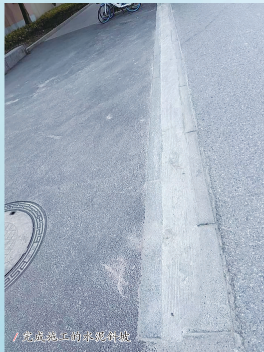
长青坊小区 门口水泥斜坡施工中
